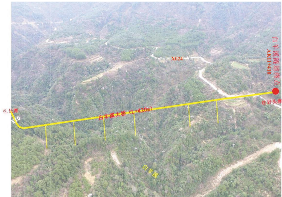
图 4.1-3 A 比较线白羊溪大桥桥位选址现状照片
